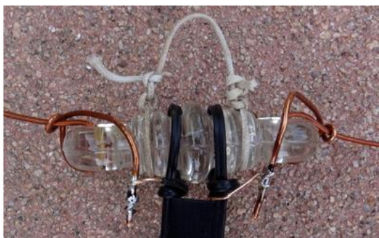
Mitte Isolator mit Zugentlastung
